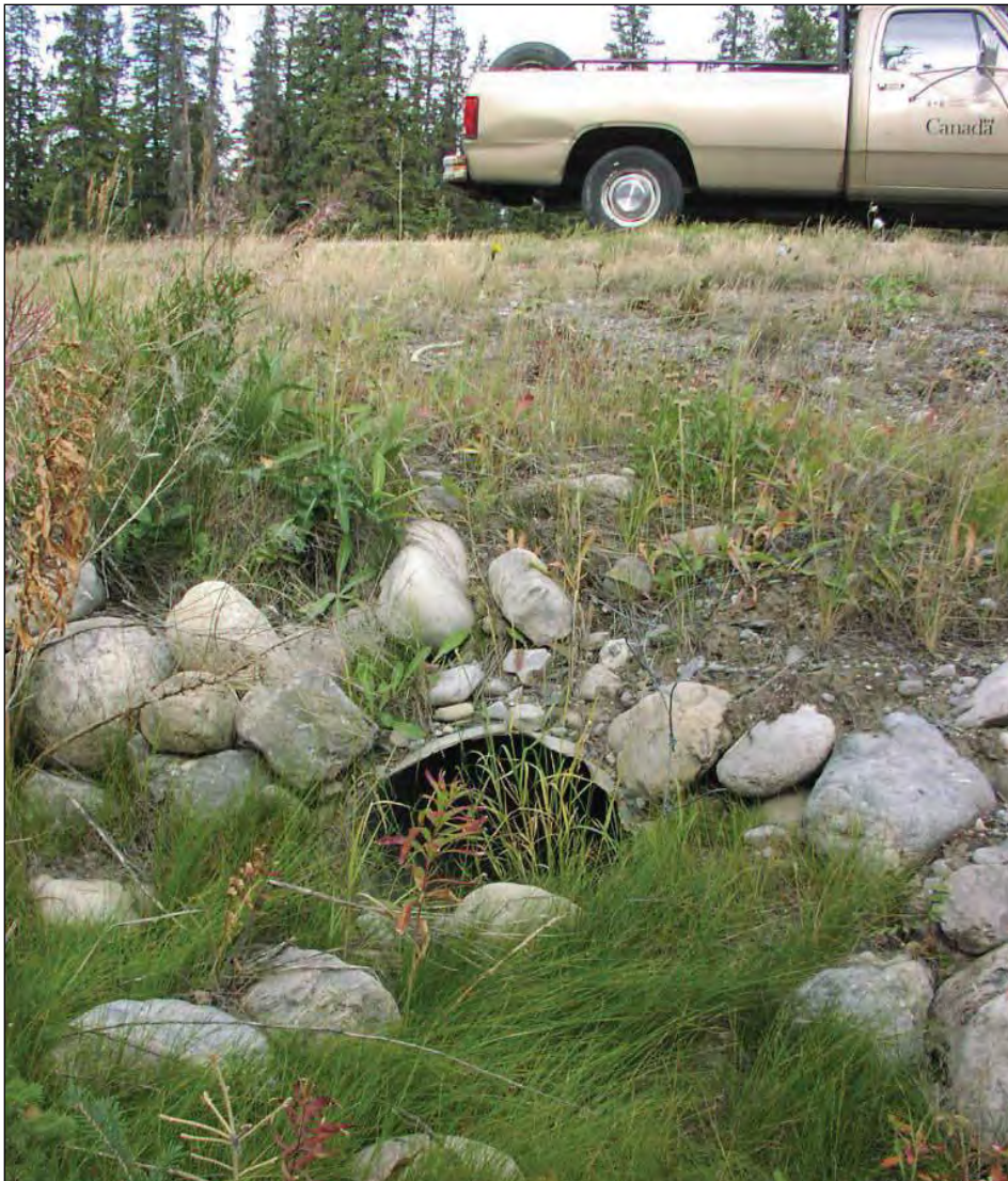
Slika 14: Primer podhoda, ki je primeren za male in srednje velike sesalce (povzeto po Wildlife crossing structures handbook ).
