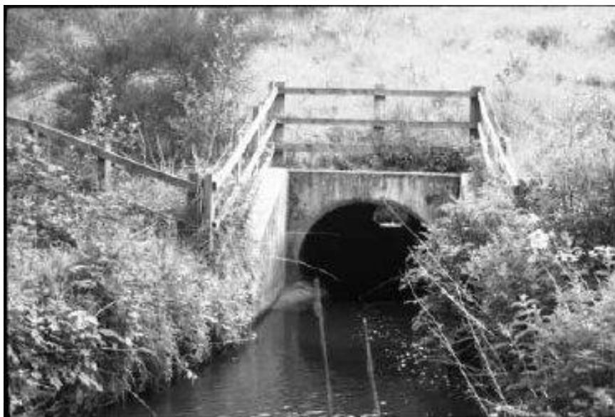
Slika 17: Tipičen neprimeren kanal (iz The Good Roads Guide).
