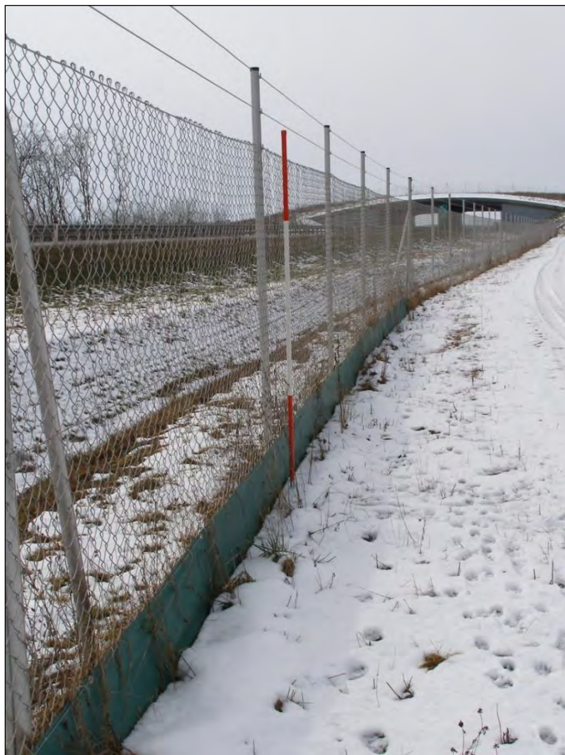
Slika 15: Primer učinkovite ograje, ki preprečuje dostop na cesto tako velikim sesalcem kot tudi manjšim. Pomembna funkcija ograje je usmerjanje živali k varnemu prehodu (nadhodu), kot ga vidimo na zgornjem delu slike.
